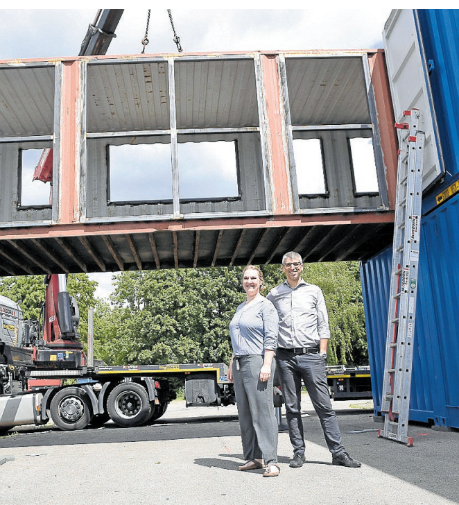
Landespfarrerin Sarah Oltmanns und Architekt Tim Driedger bei den Aufbauarbeiten für das Zentrum Jugend auf dem Fredenbaumplatz.
